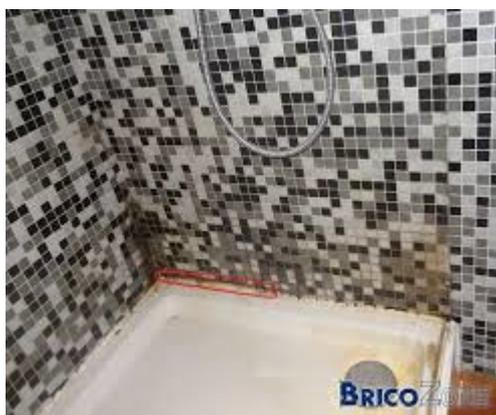
Vous avez de l'humidité sur un mur . De l'autre côté de ce mur , c'est le mur carrelé d'une douche : alors vous craignez une fuite sur tuyauteries derrière le carrelage.
