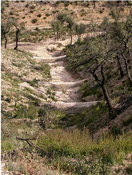
Restanques modernes en béton construites par l'[ONF](#) en travers d'un ravin dans l'[Esterel](#).
